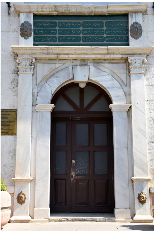
Kışlanın depo kapısı.
